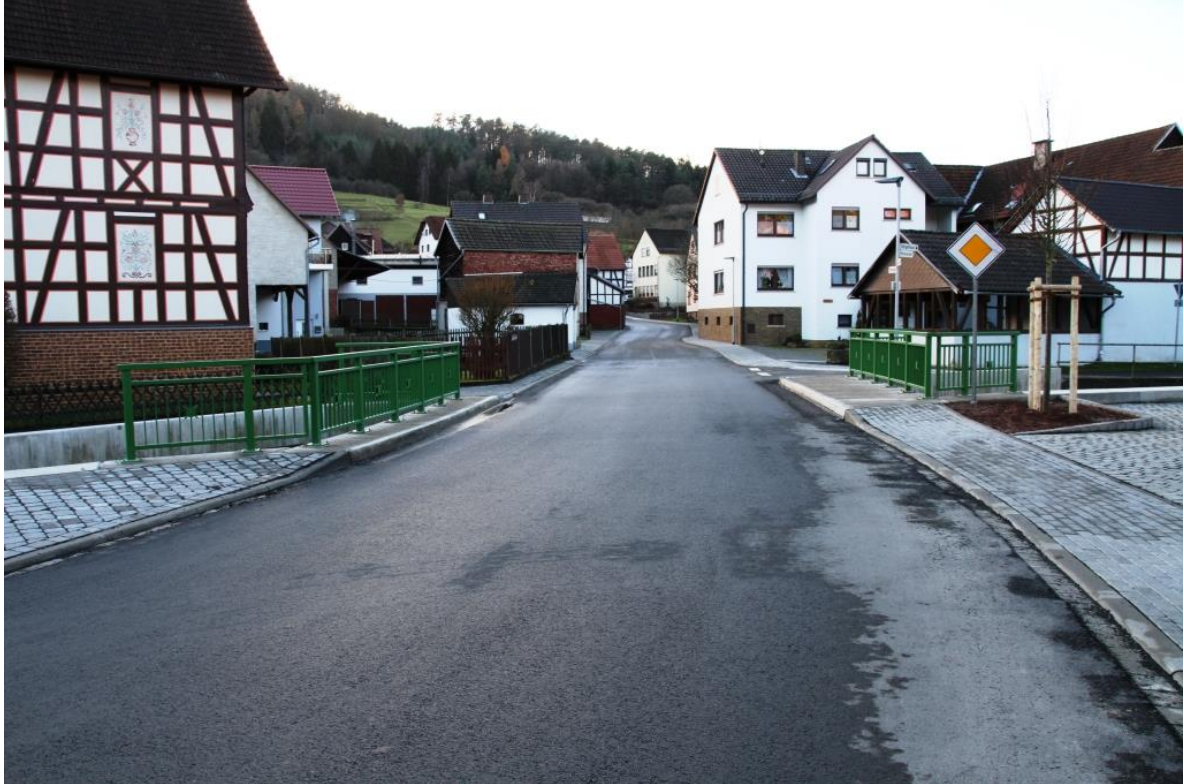
Blick von der Engelbachbrücke auf die Straße „Pferdsbach“ in Richtung Dexbach
